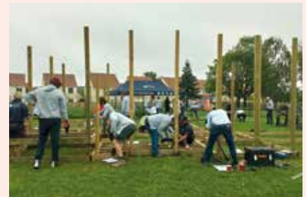
Le château en cours de construction
